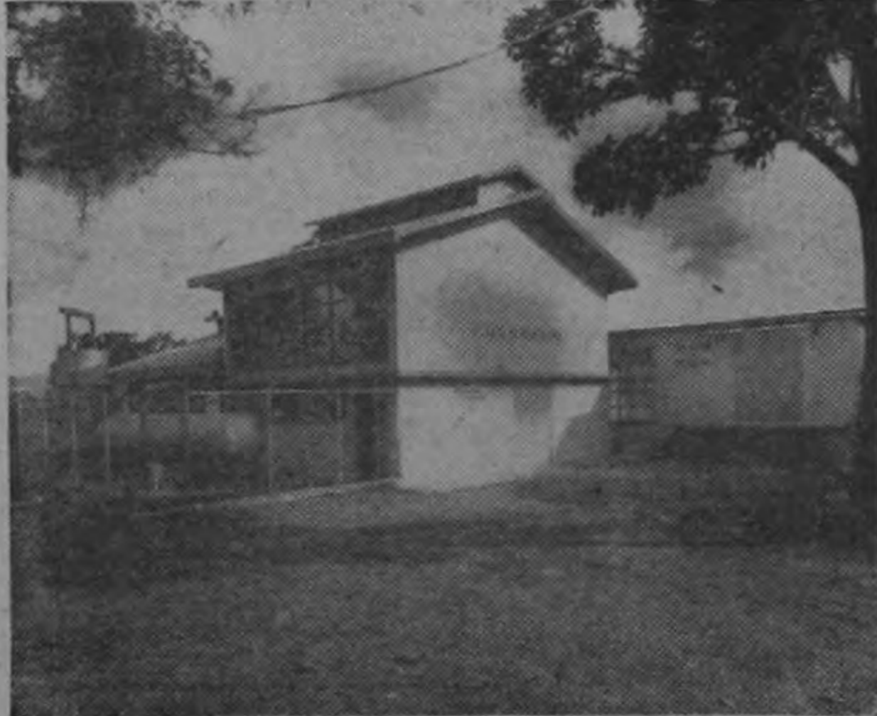
Plantas de Hidrógeno y Oxígeno. Detrás de estas plantas se encuentra el moderno Laboratorio de Control de Calidad e Investigación.
